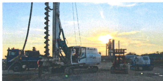
Úsek speciálního zakládání
