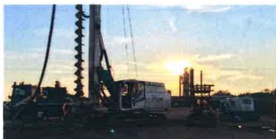
Úsek speciálního zakládání
