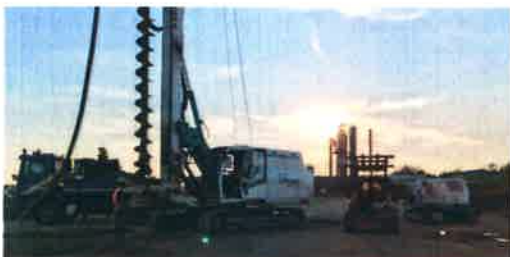
Úsek speciálního zakládání
