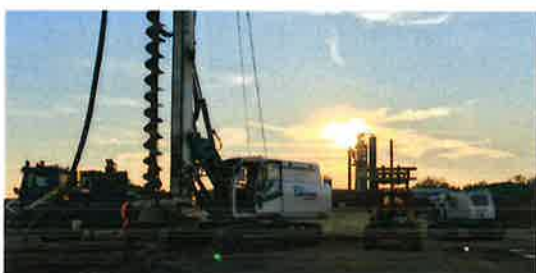
Úsek speciálního zakládání
