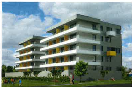
Úsek pozemních staveb
