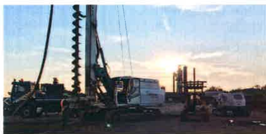
Úsek speciálního zakládání
