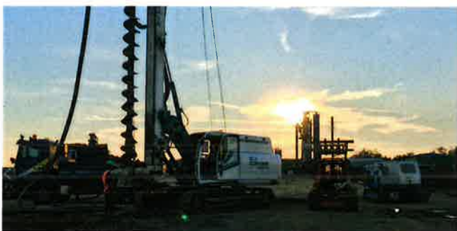
Úsek speciálního zakládání
