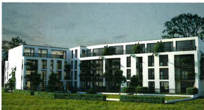
Úsek pozemních staveb
