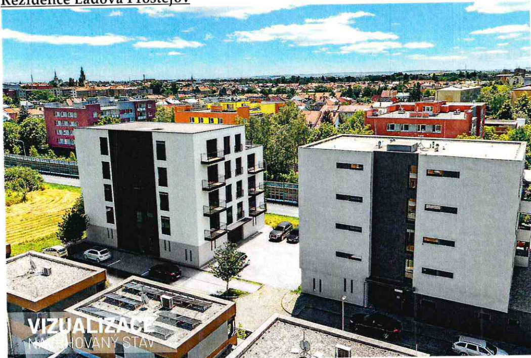
Provedení monolitických konstrukcí, zemních prací a základových a nosných zděných konstrukcí bytového domu Termín zahájení: listopad 2024
