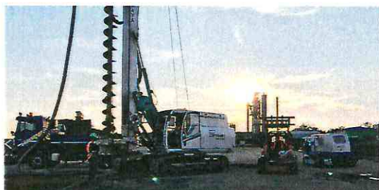
Úsek speciálního zakládání
