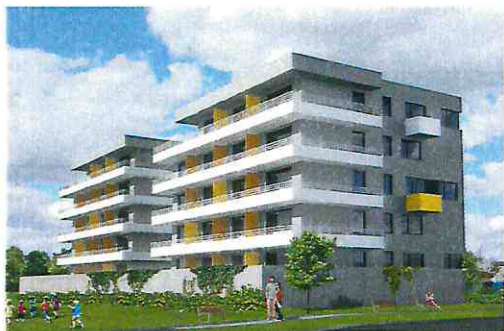
Úsek pozemních staveb
